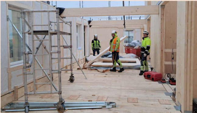
Prefab Construction | ETC Bygg
